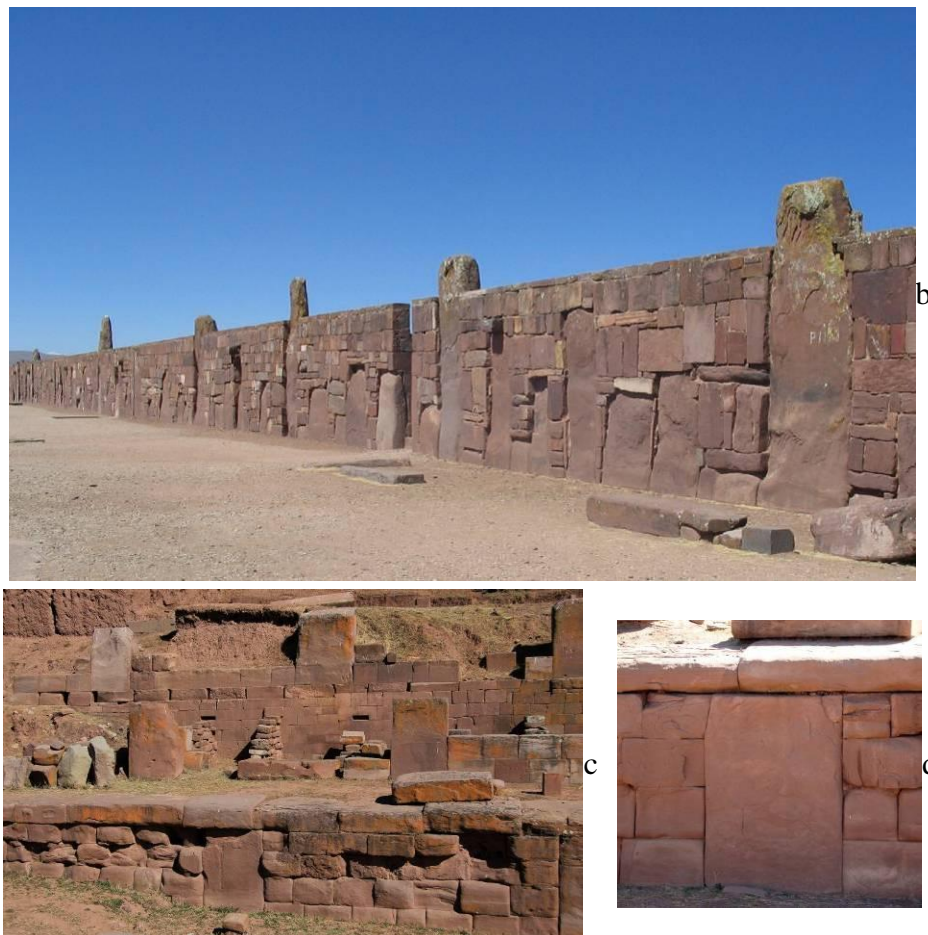
Figure 9. La disposition des piliers monolithiques dans le mode de construction des édifices de Tiwanaku intègre totalement la tradition architecturale antérieure. a et b. Vue de l'ancienne cour semi-enterrée et du mur de délimitation de la plateforme du Kalasasaya ; c et d. Détails des murs de contention des terrasses étagées composant la pyramide Acapana (photographies : F. Cuynet)
