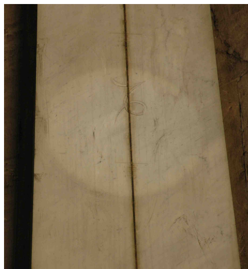
Figure 14 – Image du Soleil au voisinage du solstice d'hiver sur l'obélisque. Au-dessus et en-dessous du symbole zodiacal du Capricorne, on voit encore nettement les graduations de Le Monnier effectuées en 1743 et 1744.
