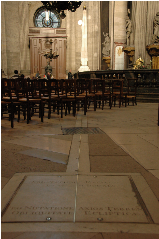
Figure 7 – La méridienne de St-Sulpice vue depuis la plaque du solstice d'été. La bande de laiton s'étire au sol du Sud vers le Nord sur près de 40 m et remonte sur près de 12 m sur l'obélisque en hiver.
