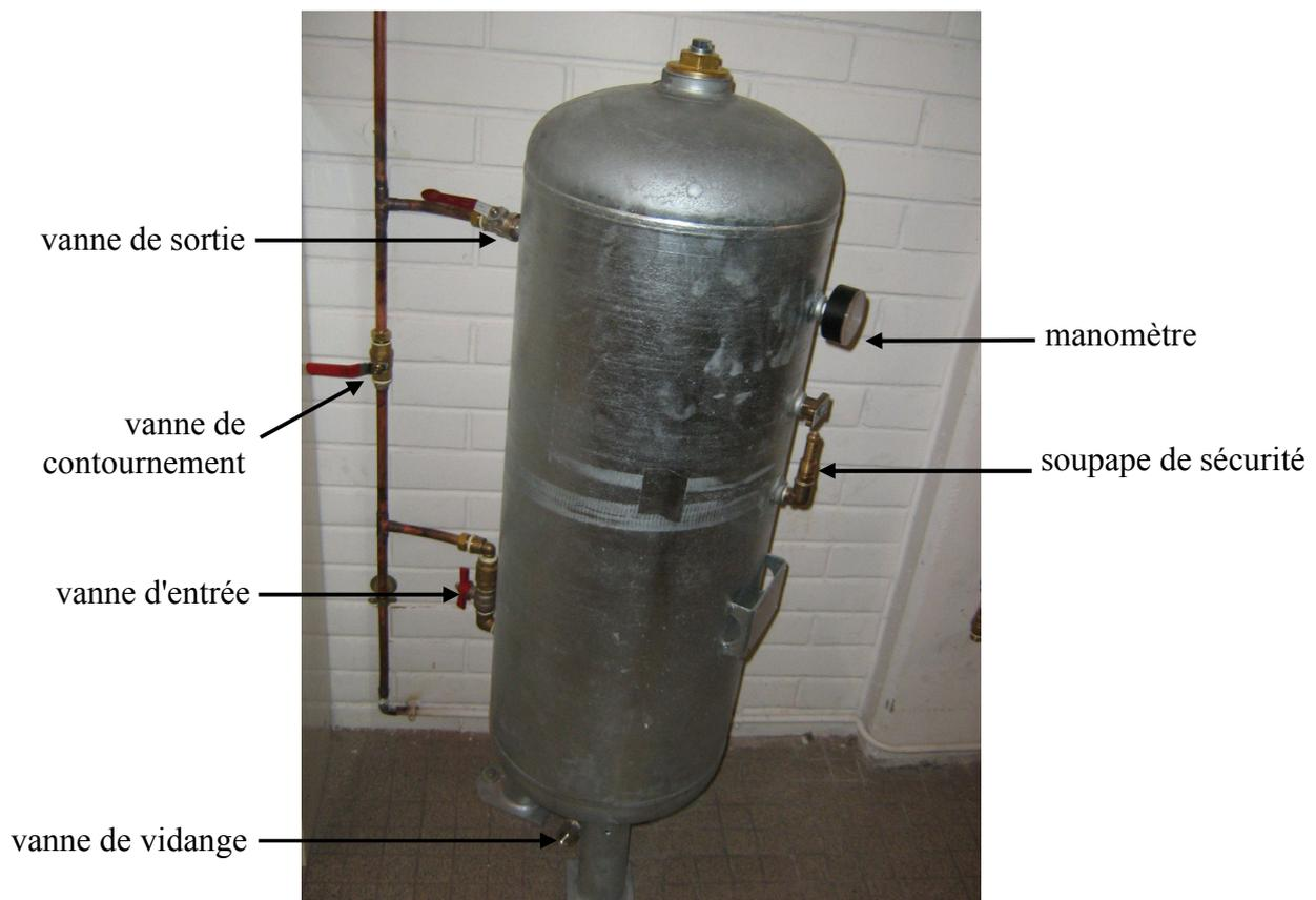
Figure 4 : cuve d'expansion
