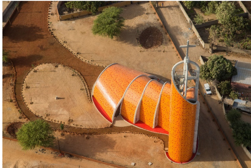
Figure 1. Nianing Church, Sénégal (© Régis L’Hostis/IN SITU Architecture).
