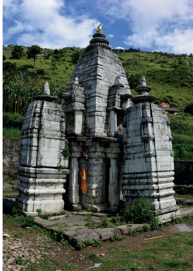
Figure 8. — Ensemble de cinq temples ( pañcadeval ) à Manma (district de Kalikot), XIV e -XV e siècle. Vue depuis le sud-ouest.
