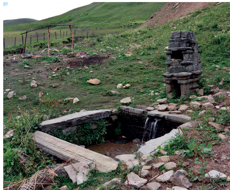
Figure 12. — Temple sur fontaine à Gotichaur (district de Jumla), XIV e -XV e siècle. Vue du sud-est.
