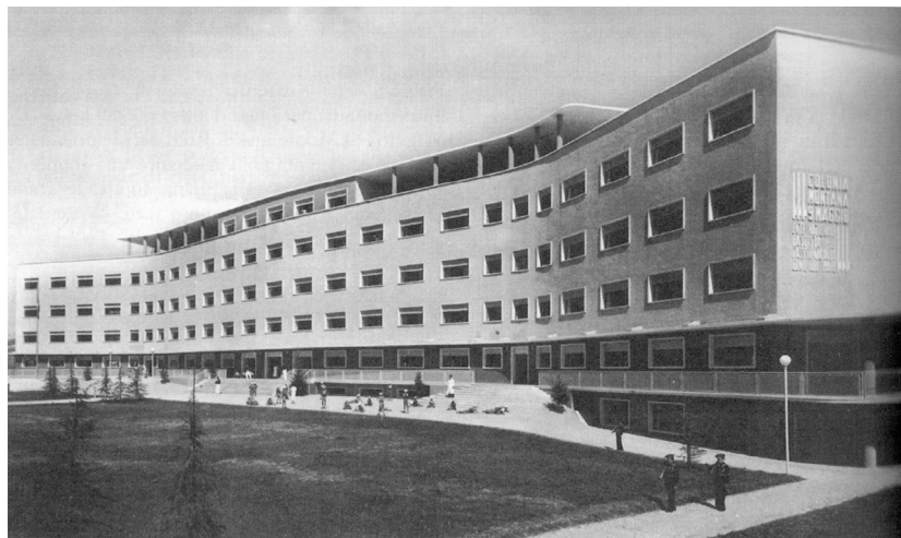
Fig. 5. Foto dell'edificio della Colonia Montana Gente del Mare e dell'Aria - IX maggio (1937) poi sede della Facoltà di Ingegneria dell'Università dell'Aquila dal 1968 (archivio privato dell'autore).
