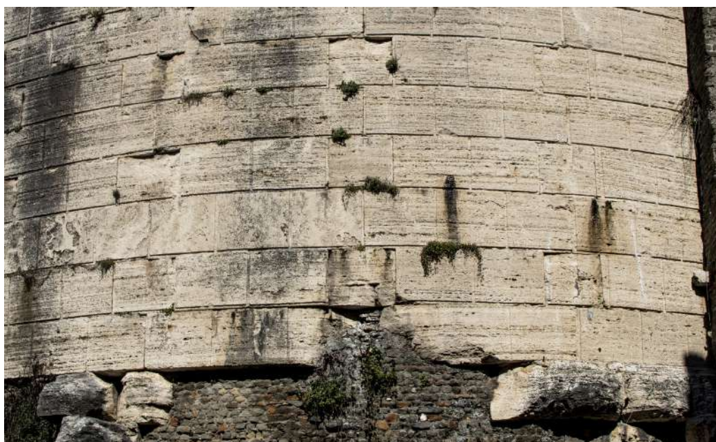
Fig. 02. Immagine fotografica di dettaglio dei blocchi di travertino trattati come un finto bugnato. (fotografia dell'Autore).
