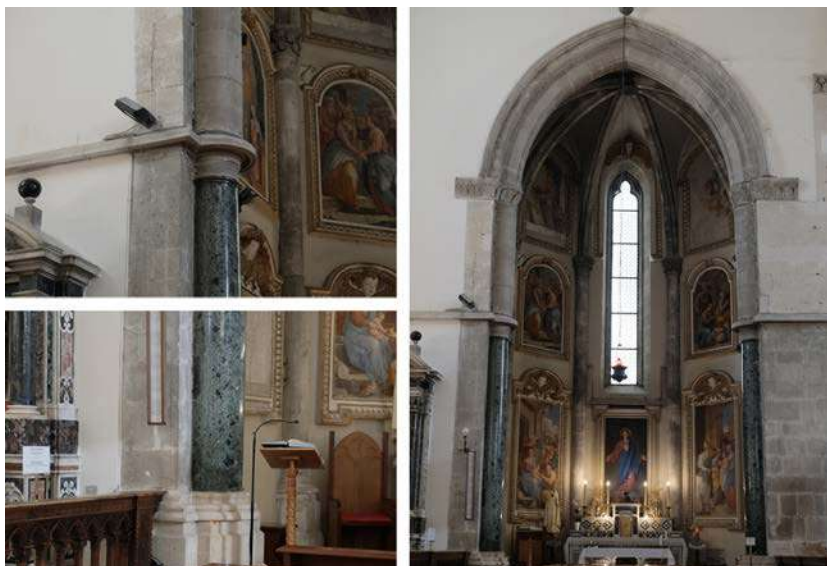
Fig. 5. Lucera. Cattedrale di Santa Maria Assunta. Arco di accesso all'abside settentrionale e particolare della base e del capitello di restauro (foto dell'autrice).
