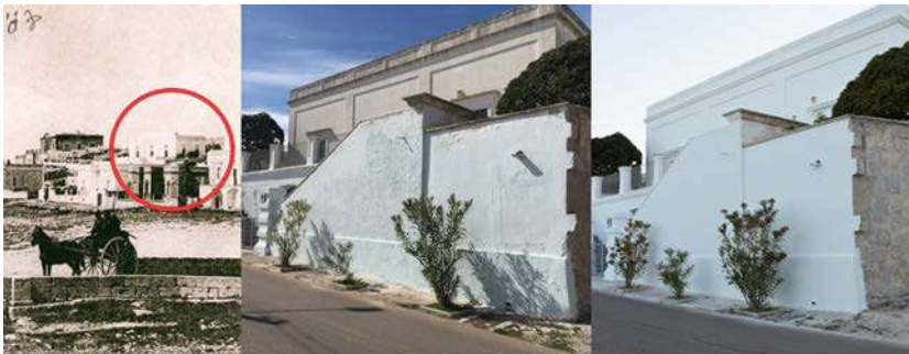
Fig. 4. Casino Cantoro in una foto del 1908 a sinistra (tratta dalla relazione tecnica) e nelle immagini ante operam al centro (documentazione fotografica allegata alla relazione tecnica, marzo-aprile 2020) e post operam a destra (foto dell'autrice). Maggio 2021.
