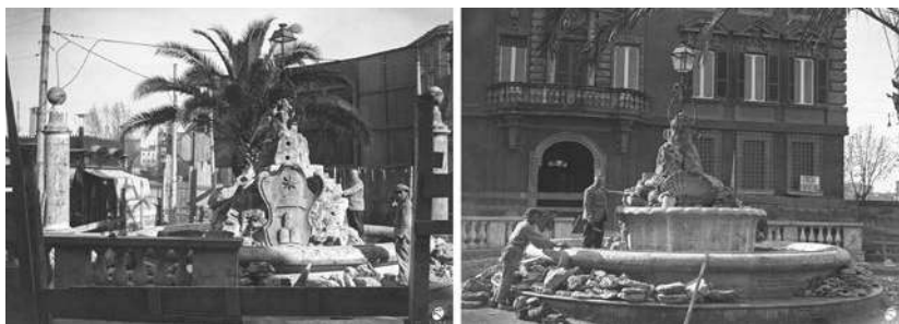
Fig. 3. La fontana nel 1930 mentre viene rimontata da alcuni operai (foto Archivio Luce). Fornita di una vasca circolare dall'orlo più ampio, la fontana ha conservato in parte gli elementi del progetto originario: al centro una nuova tazza a forma di conchiglia raccoglie l'acqua che fuoriesce dalle bocche di due delfini mitologici che richiamano nell'aspetto gli originali. La vecchia tazza è stata integrata nella nuova composizione. Permangono lo stemma della famiglia Albani e la stella in ferro battuto. Sulla sommità la lanterna rimossa nel 2014.
