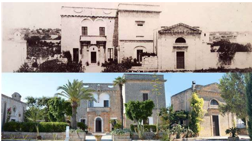
Fig. 5. Complesso Romasi nell'immagine d'epoca in alto (foto De Angelis, 1891) e dopo i recenti lavori di restauro rispettosi del valore di 'palinsesto' (foto dell'autrice). Luglio 2020.
