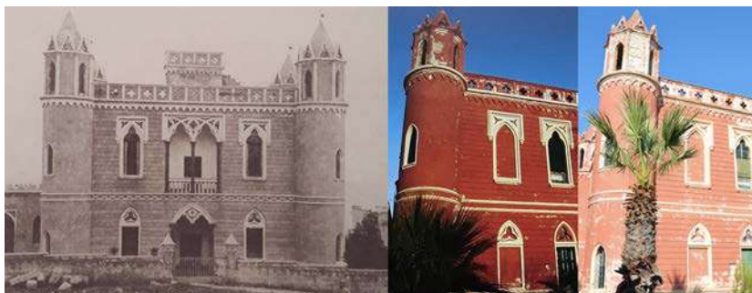
Fig. 3. Villa Mellacqua nell'immagine storica a sinistra (foto De Angelis, 1891) e in due scatti recenti che colgono le modifiche intervenute nell'uso dei colori (al centro, particolare di una foto da Inguscio 2006, p. 86; a destra foto dell'autrice). Luglio 2020.
