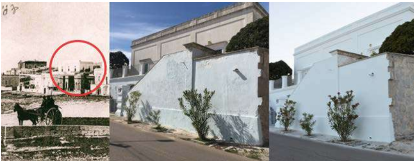
Fig. 4. Casino Cantoro in una foto del 1908 a sinistra (tratta dalla relazione tecnica) e nelle immagini ante operam al centro (documentazione fotografica allegata alla relazione tecnica, marzo-aprile 2020) e post operam a destra (foto dell'autrice). Maggio 2021.
