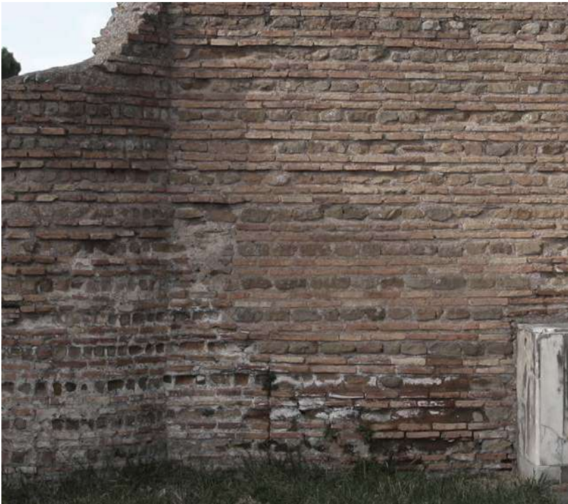
Fig. 7. Prospetto nord del viridarium in cui si rileva l'addossamento, con soluzione di continuità, della muratura del ninfeo con l'abside del tablinium (foto dell'autore).
