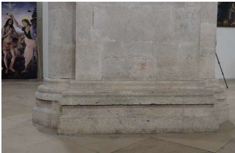
Fig. 2. Lucera. Cattedrale di Santa Maria Assunta. Base dei pilastri delle navate (foto dell'autrice).
