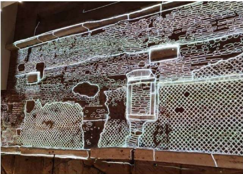
Fig. 3. Proiezione del rilievo architettonico sulla struttura dell'Acquedotto Vergine (foto di Mauricio Chaves).
