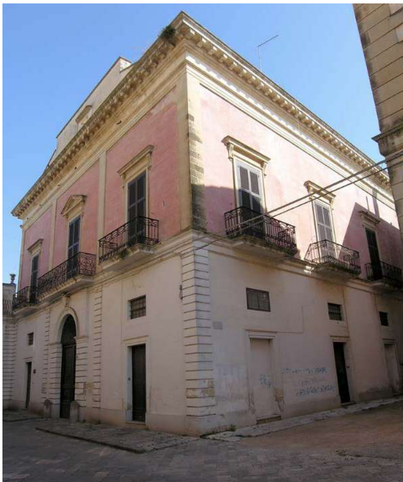
Fig. 2. Nardò, Palazzo Tafuri in via G. Zuccaro, fine sec. XIX, veduta attuale (foto dell'autore).
