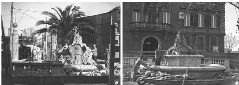
Fig. 3. La fontana nel 1930 mentre viene rimontata da alcuni operai (foto Archivio Luce). Fornita di una vasca circolare dall'orlo più ampio, la fontana ha conservato in parte gli elementi del progetto originario: al centro una nuova tazza a forma di conchiglia raccoglie l'acqua che fuoriesce dalle bocche di due delfini mitologici che richiamano nell'aspetto gli originali. La vecchia tazza è stata integrata nella nuova composizione. Permangono lo stemma della famiglia Albani e la stella in ferro battuto. Sulla sommità la lanterna rimossa nel 2014.
