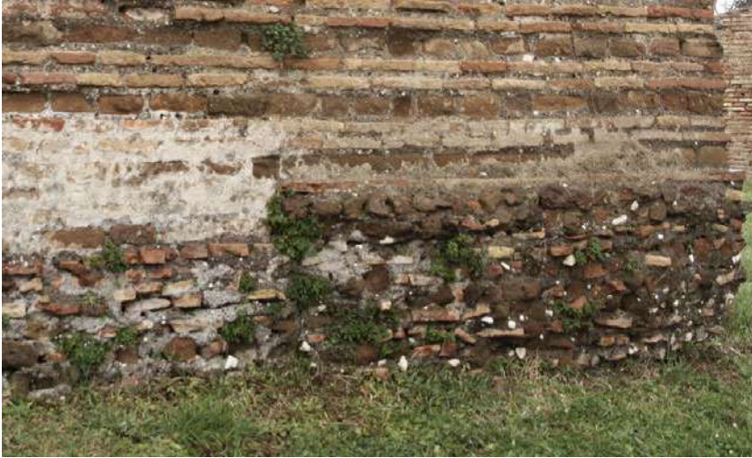
Fig. 6. Fondazione a vista sul prospetto sud-est (foto dell'autore).
